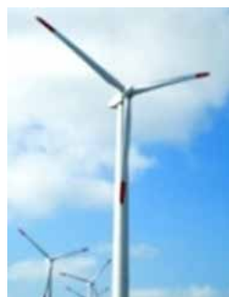
大型風力発電システム
